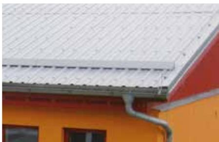
Zur Montage auf Trapezprofil, ohne Eisstopper
