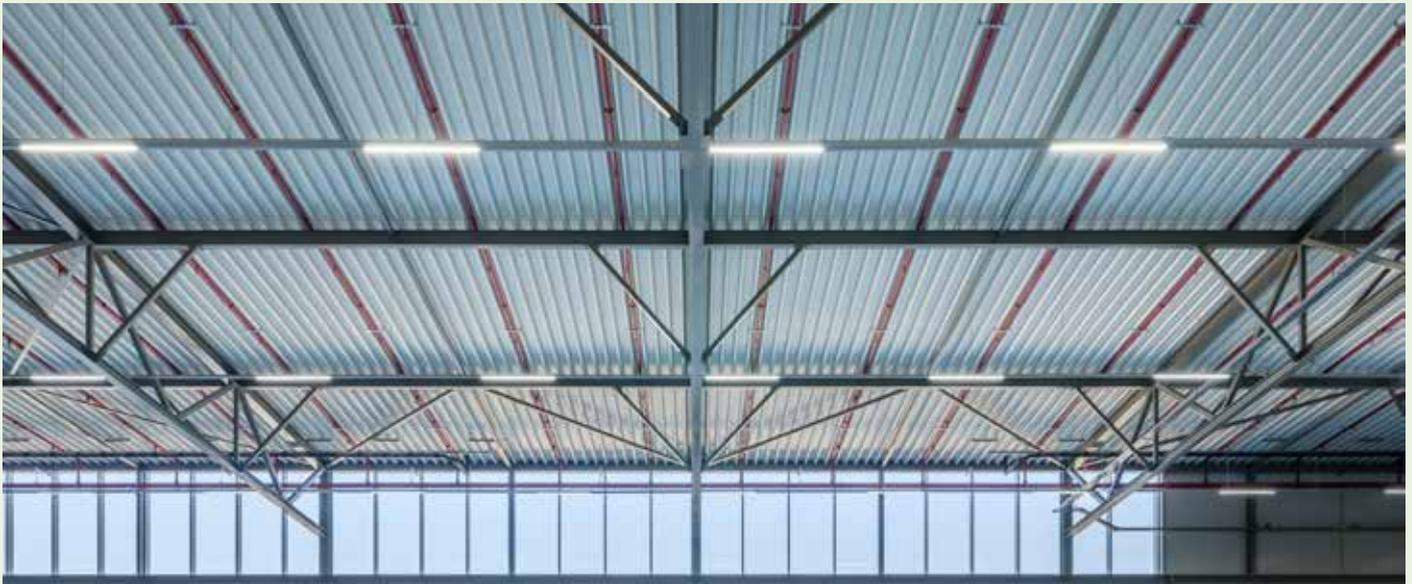
Selbsttragende Hochprofile im Einsatzbereich als Warmdachunterkonstruktion oder im Kaltdachbereich ungedämmt in Negativ-Verlegung. Je nach Geometrie und Materialstärke können große Spannweiten erzielt und den Gegebenheiten angepasst werden. Zusätzlich können akustische Anforderungen durch seitliche Akustiklochungen erzielt werden. Im Kaltdachbereich kann ein zusätzlicher Vlies Kondensatbildung aufnehmen. **Beachten:** Nicht bei jeder Materialstärke und Geometrie möglich!
