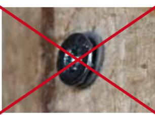
Verankerungsmittel an der Unterkonstruktion versenken.
