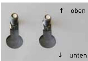
**(6)** Einsetzen der MVP-Schrauben in die PLANBOND INVISIO® Bohrung mit Hinterschnitt.
