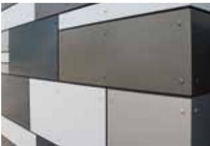
MAAS PLANBOND® werden hauptsächlich als Bekleidung von vorgehängten hinterlüfteten Fassaden (VHF) verwendet.
