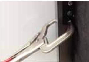
**(4)** Tragprofile mit Gripzange fixieren. Tragprofil an *TEKOFIX*® anschrauben.
